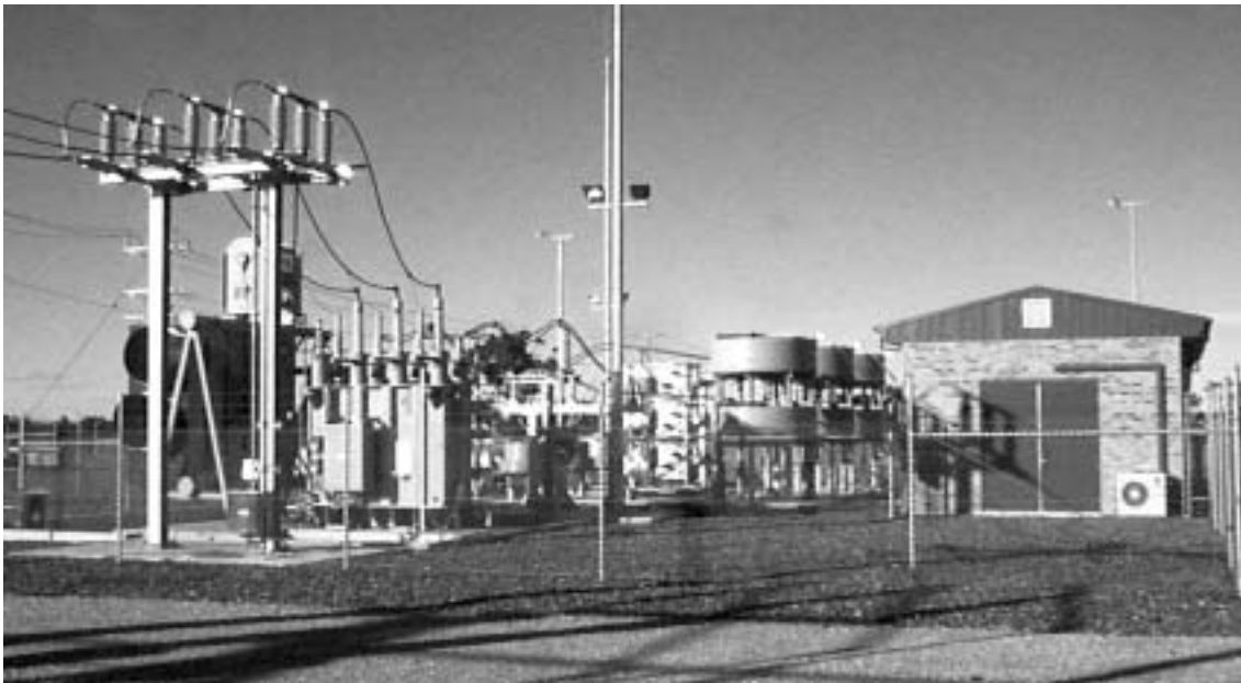
Ilustración 20: SVC fabricado por Alstom de +30/-25MVAR en 66kV
